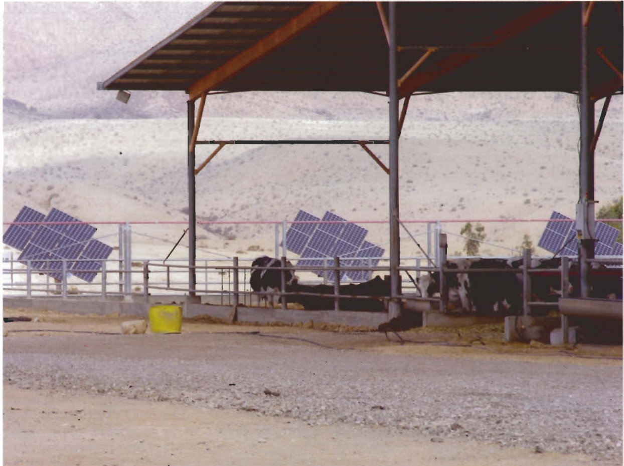
פרות ויחידות עוקבות בחוות טנא. בחווה שמונה יחידות עוקבות של 2 kW כל יחידה, ועל גג הרפת מותקנת מערכת קבועה של 34 kW.
